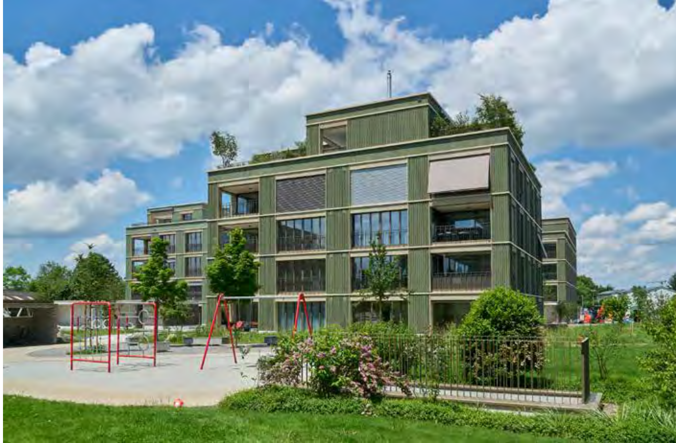
Perfekter Brandschutz: Flumroc-Steinwolle für die «Oase Beckenhof» in Sursee.
