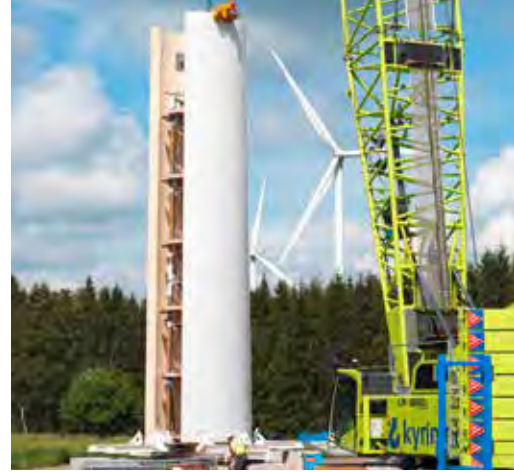
Aufeinandermontierte Module bilden einen hohlen Turm mit Zwischenpodesten.
