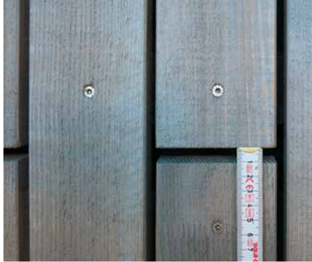
Fassaden mit offenen Fugen sind architektonisch gefragt. Hier wurden die Traglatten schwarz gestrichen und sind nicht erkennbar.
