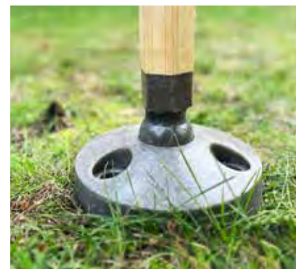
Gelenkiger Fusspunkt aus CFK-bewehrtem Polymerfeinbeton.
