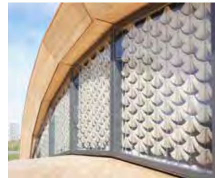
Die Beschattungselemente verformen sich je nach Temperatur und Feuchtigkeit wie Zapfen.
