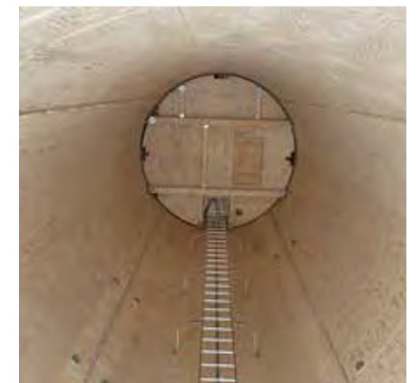
Blick im Turm nach oben: Die Segmente könnten wieder demontiert werden.
