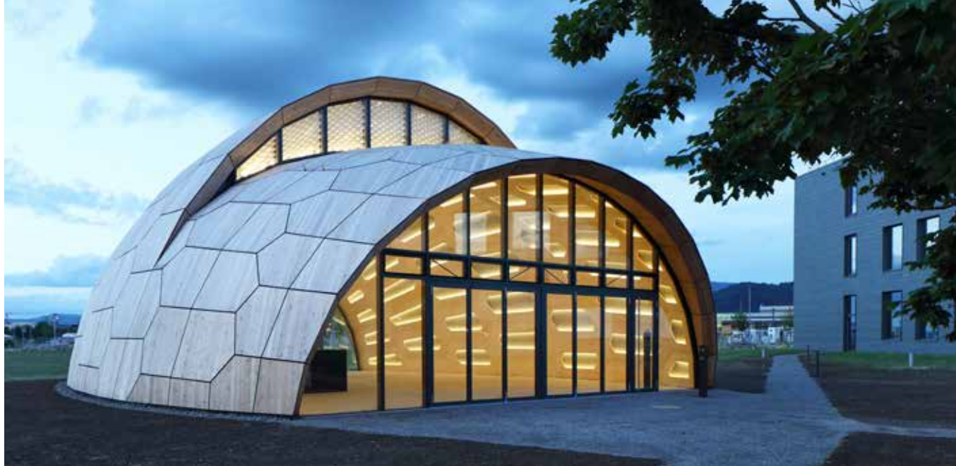
Die wetterresponsive Fassade mit dem Oberlicht, die hochgedämmte Gebäudehülle und die aktivierte Bodenplatte schaffen einen ganzjährig thermisch komfortablen Raum, ohne dass weitere Haustechnik erforderlich ist.
