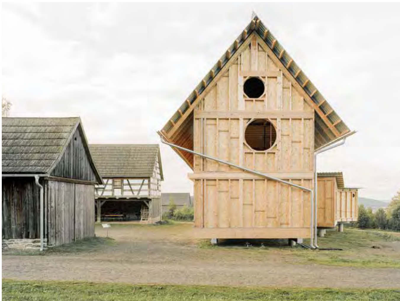
Das Lernhaus im Freilandmuseum Oberpfalz (DE) nimmt die Position des alten Wohnhauses ein und bleibt absichtlich ein Rohbau.
