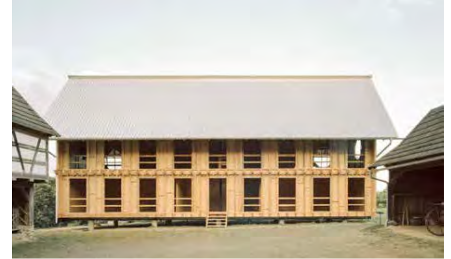
Freiräume sind offen für eine lernende Baustelle. Themen sind Kreislaufwirtschaft, Materialeffizienz, Reversibilität und Gebäudefussabdruck.
