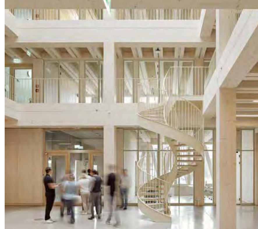
Die sichtbare Holzkonstruktion wie auch die Holzbalken für Decken und Schalungen aus Holzwohle-Leichtbauplatten wurden im Werk der Blumer-Lehmann AG in transportfähiger Grösse vorgefertigt.
