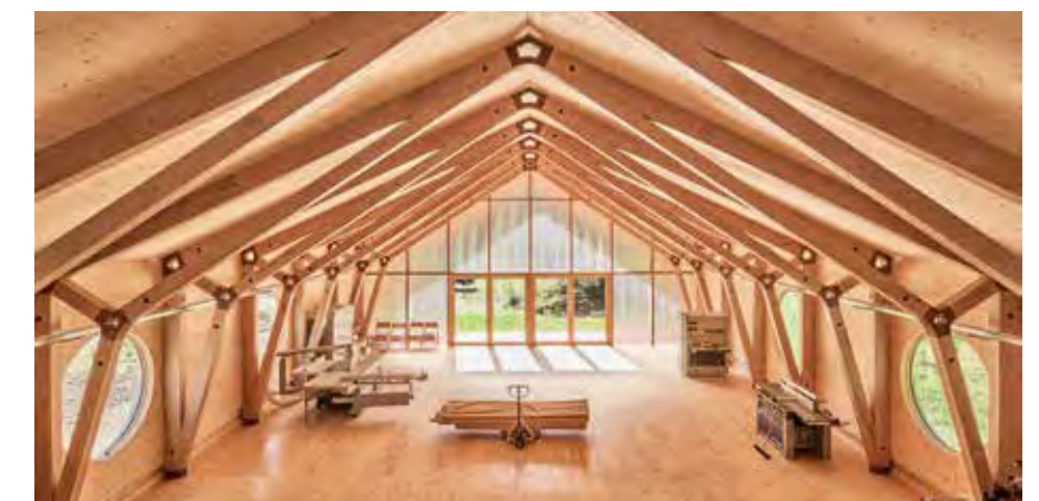
Die Forschungshalle bildet den Auftakt für den geplanten Holzbau-Campus der RPTU.
