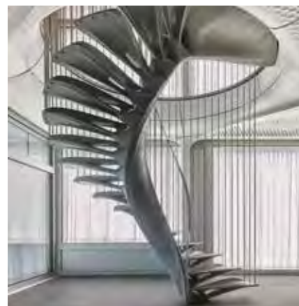
Mit Computertechnologie haben die Forschenden Betonelemente geschaffen, die nur aus dem statischen Minimum bestehen.
