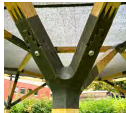
Mehrdimensionaler, lösbarer Knoten am Übergang Stütze-Dachkonstruktion.
