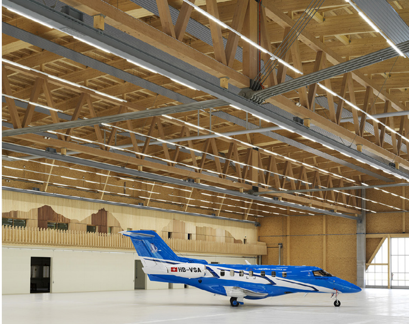
Die Dimensionen der Holztragwerke werden immer grösser, darum empfiehlt sich unter gewissen Umständen das Monitoring der Holzfeuchtigkeit.
