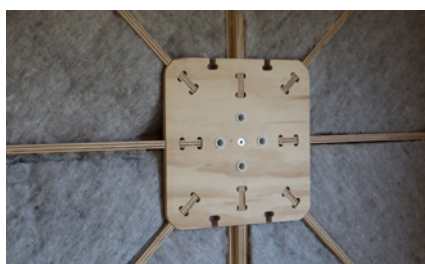
Die Sperrholzplatten haben integrierte Clips für die Verkleidung.
