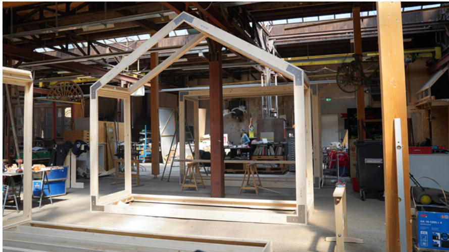
Aus leichten Holzelementen und robusten Verbindungsteilen sind beliebige Module für unterschiedliche Nutzungen erstellbar.
