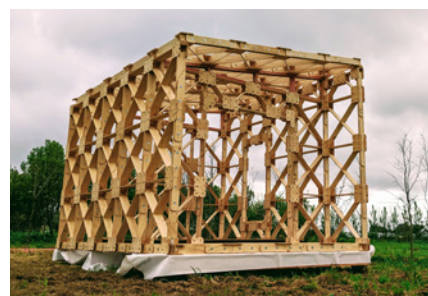
Kein Leim und keine Nägel: nur Holz und Clips.
